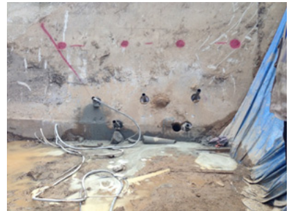
(f) 하단 강관파이프 설치 및 그라우팅 작업
