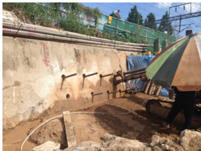
(g) 상단 강관파이프 설치 및 그라우팅 작업
