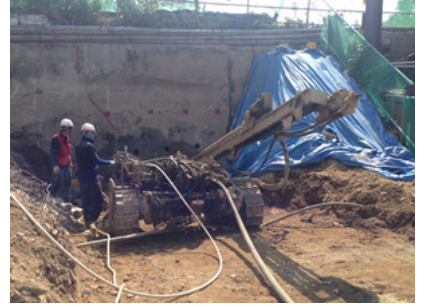
(c) 천공기(C6)를 이용한 천공
